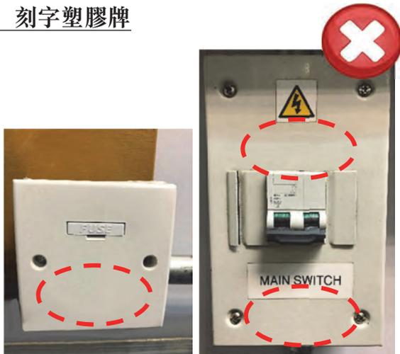
電表通訊設備的木板、熔斷器的連接盒和總開關未有提供“DO NOT DISTURB (FOR HK ELECTRIC ONLY) 請勿干擾 (港燈專用)”的刻字塑膠牌及總開關未有同時提供“6A DOUBLE POLE MCB FOR TMC OF HK ELECTRIC 6 安培雙極斷路器供電子港燈電表通訊”的刻字塑膠牌。
