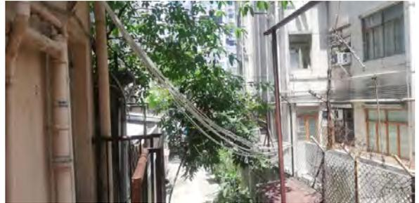
地面上的臨時電纜，在安裝和施工期間，公眾和施工人員的安全極為重要，包括如何選取及設計適當的設備，加強監察運作狀況，提升電氣和機械保護、體力處理操作、在夜間作業的安全和防止絆倒途人。
