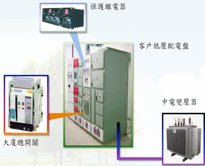
圖 2：電力公司及客戶設備的连接
