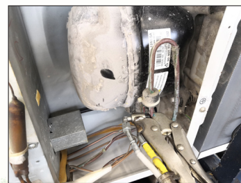
圖 1 用於夾緊雪櫃或冷氣機的冷凝器盤管的抽吸鉗
