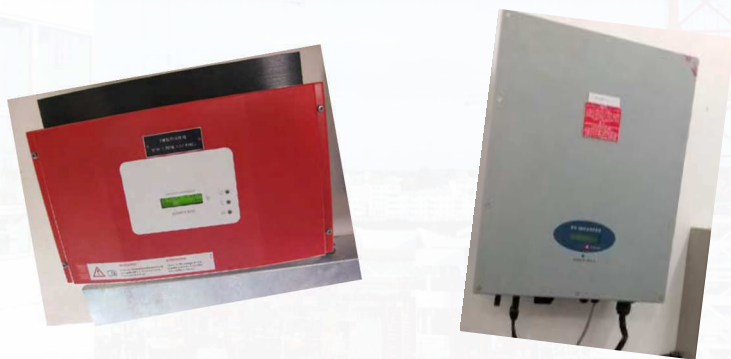
圖 2：設有「防孤島」功能的逆變器
